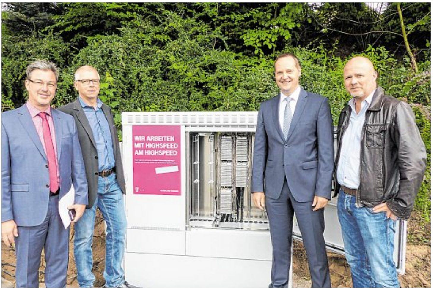
Ralf Engstfeld (Ansprechpartner für den Vectoring-Ausbau), Christian Mewes (Techniker), Peter Weber (Bürgermeister) und Thomas Stupperich (Tiefbauamt) freuen sich über den Vectoring-Ausbau (v. l.), der gestern offiziell in Dahl/Friedrichsthal begann. Foto: adz
